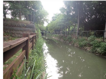
後段現場環境樣貌
