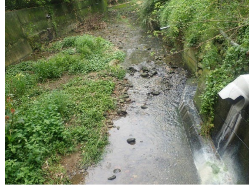
兩側皆為混凝土
