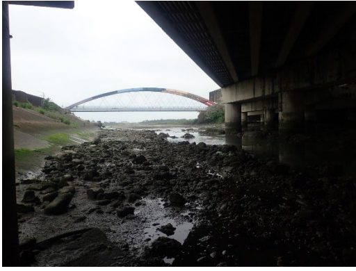
出海口泥沙淤積嚴重，水色混濁
