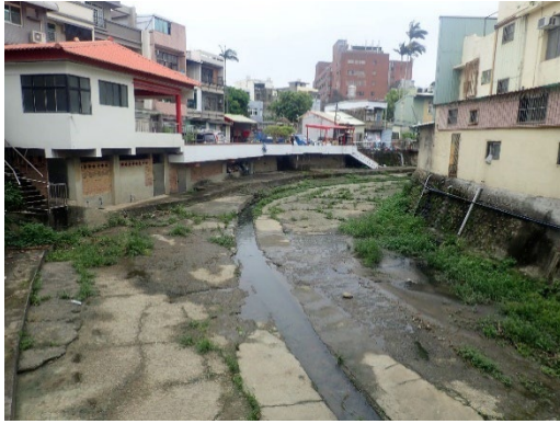
兩側皆為混凝土岸
