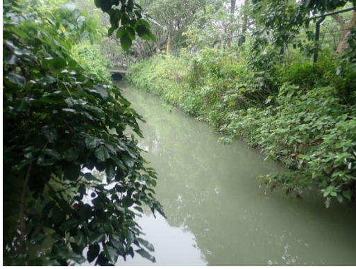
兩側為網籠護岸及自然土堤
