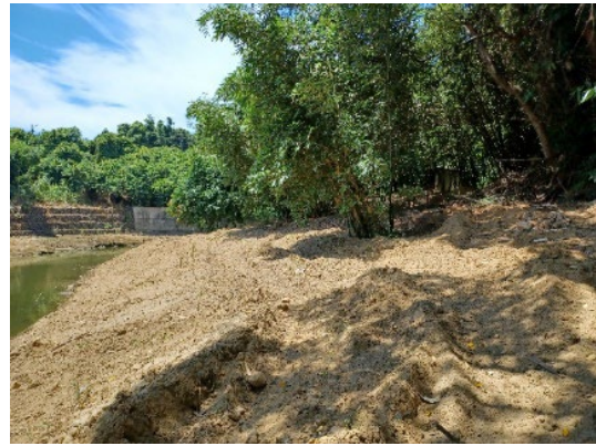
溪岸灘地皆為工程干擾
