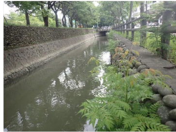
中段現場環境樣貌
