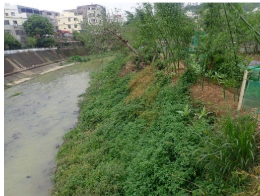
左岸為混凝土岸，右岸為自然土堤
