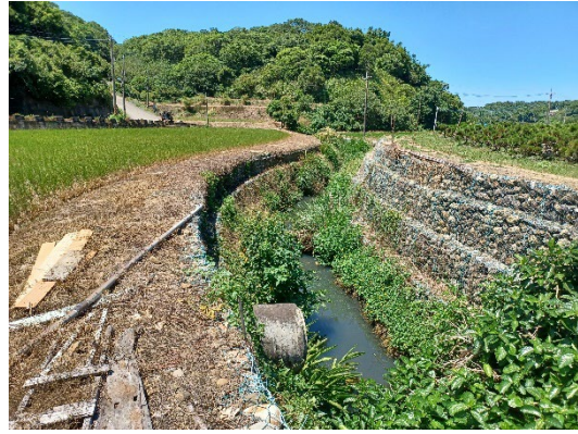
部分河段為石籠護岸
