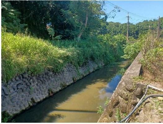
河道兩側皆為混凝土鋪面
