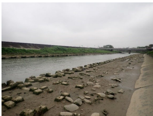
兩側皆為混擬土岸，左岸大面積消波塊
