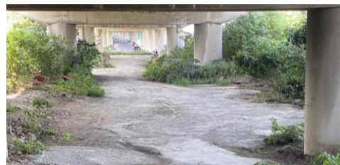
⑧ 出入口橋下空間寬敞
