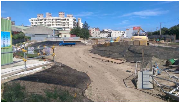
資料來源: 竹市微笑水岸計畫 概述: 施工中
