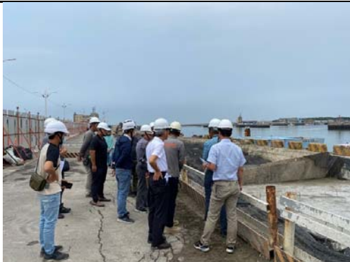
資料來源:竹市微笑水岸計畫 概述: B4-2 施工中
