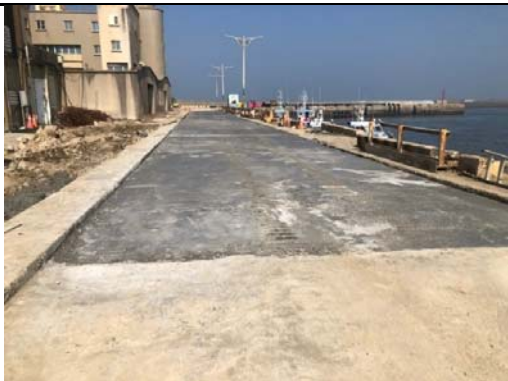
資料來源:竹市微笑水岸計畫 概述: B3-2 施工中
