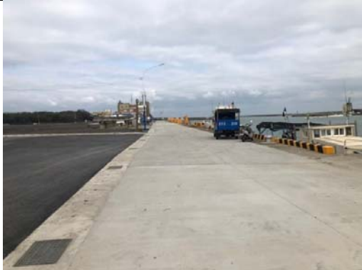
資料來源:竹市微笑水岸計畫 概述: B3-2 完工後
