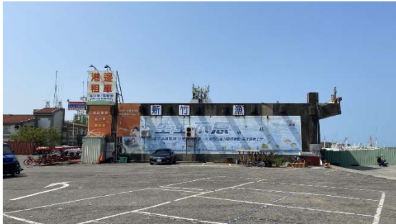
資料來源:竹市微笑水岸計畫 概述: B4-2 施工前
