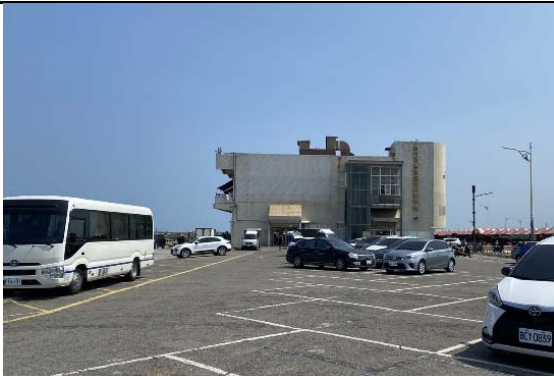
資料來源:竹市微笑水岸計畫 概述: B4-2 施工前
