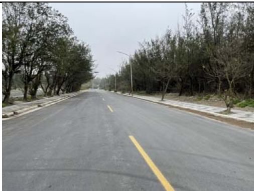
資料來源:竹市微笑水岸計畫 概述: B4-2 完工後
