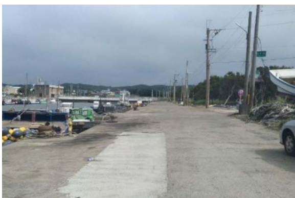
資料來源:竹市微笑水岸計畫 概述：B3-2 施工前
