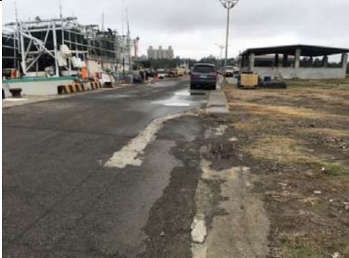
資料來源:竹市微笑水岸計畫 概述: B4-2 施工前
