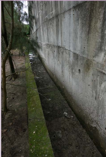
日期：113 年 5 月 14 日 位置：①水泥排水溝
