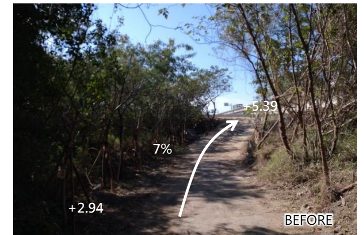
C 現有動線坡度較陡不易騎行
