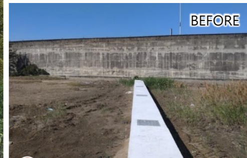
H 現有排水溝設施位於棲地中央
