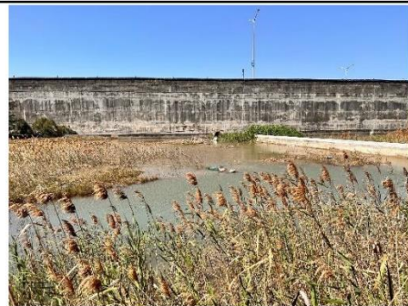
基地內排水管溝
