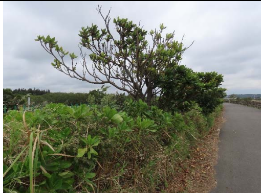
1. 自行車道平面段綠帶植栽： 現場有根據圖說種植大葉山欖、草海桐及三葉蔓荊。
