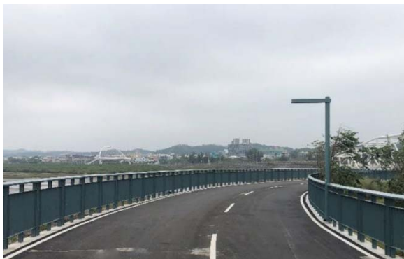
資料來源:竹市微笑水岸計畫 概述: 施工後
