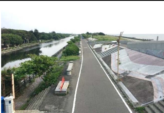
資料來源:竹市微笑水岸計畫 概述: 施工前
