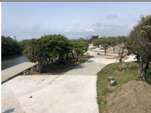
資料來源:竹市微笑水岸計畫 概述：施工中
