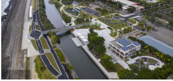
資料來源:竹市微笑水岸計畫 概述：完工後
