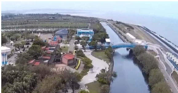
資料來源:竹市微笑水岸計畫 概述:施工前
