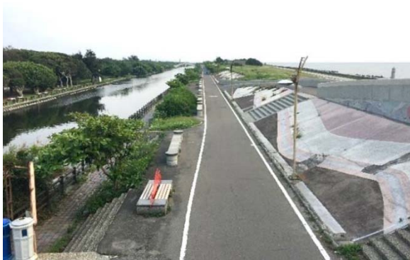
資料來源:竹市微笑水岸計畫 概述:施工前
