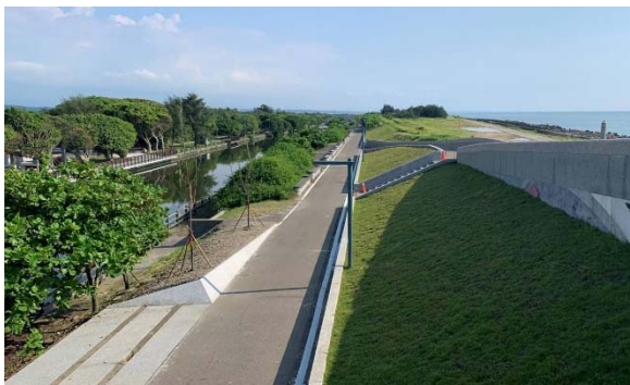
資料來源:竹市微笑水岸計畫 概述：完工後
