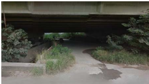
概述：柯子湖溪出入口-施工前(註2)
