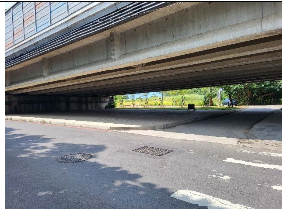
概述：維管階段-古賢出入口 日期:2023/7/11
