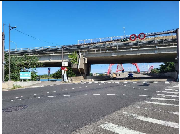
概述：維管階段-左岸舊港出入口 日期:2023/12/13
