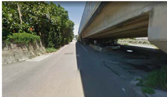
概述：古賢出入口-施工前(註 2)
