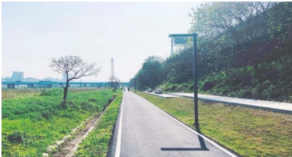
資料來源:竹市微笑水岸計畫 概述：完工後
