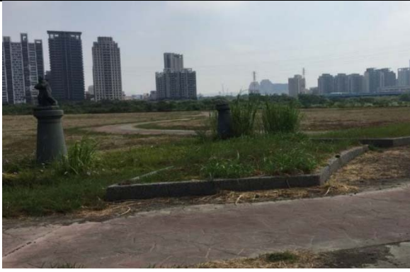
資料來源:竹市微笑水岸計畫 概述：施工前
