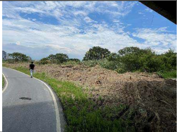
已掘除植群(蘆竹保留) 110.05.27
