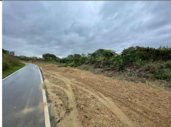
已掘除植群(蘆竹保留) 110.11.26
