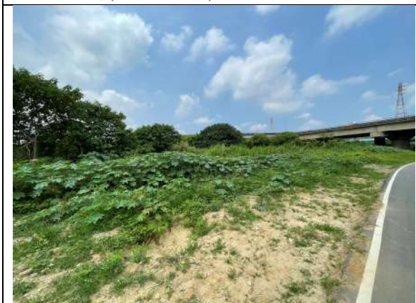
已掘除植群(蘆竹保留) 110.07.16
