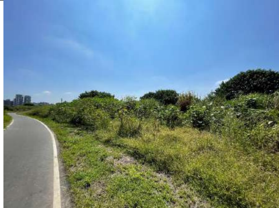
已掘除植群(蘆竹保留) 110.09.29
